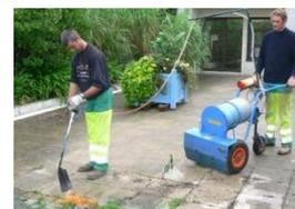
Le **désherbage mécanique à énergie électrique** présente l'avantage de légèreté et de maniabilité de l'équipement (il s'agit de batterie électrique porté sur le dos) et la moindre nuisance sonore pour le voisinage.
