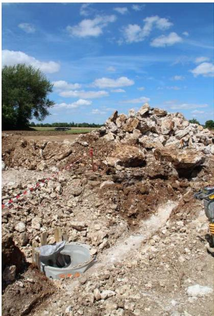
Gros travaux de fondations pour les réseaux enterrés (eaux pluviales et usées, gaz, électricité, téléphone).
